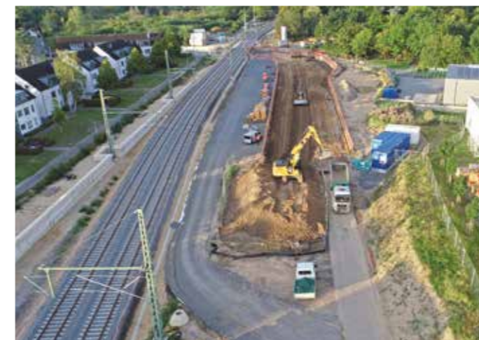
Enorme Herausforderung Der Streckenausbau erfolgt in größtenteils dicht besiedeltem Gebiet.
